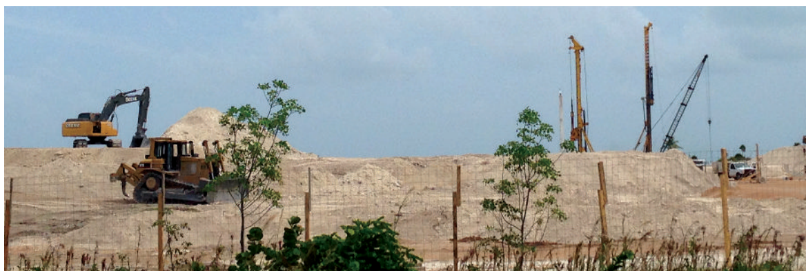
Construcción hotelera en Playa Mujeres.
