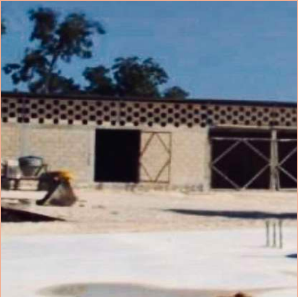
Figura 04: Bodega de obra. Por: JMMM.
