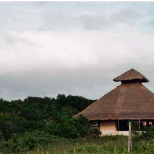
Figura 19: Cubierta autoventilada tipo palapa. Por: MMD.
