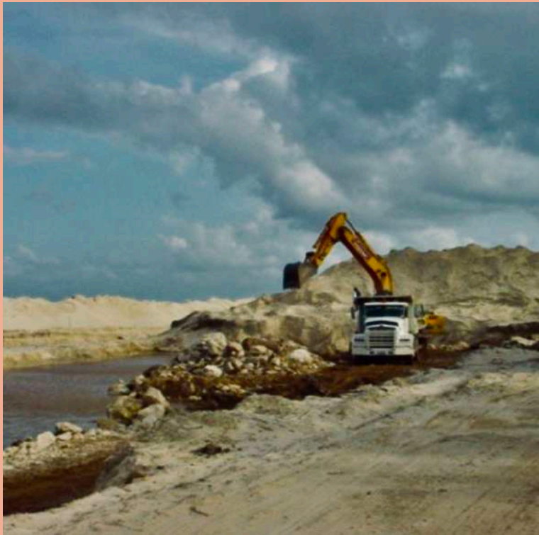
Figura 13: Etapa de excavación hasta estrato resistente. Por: LAAG
