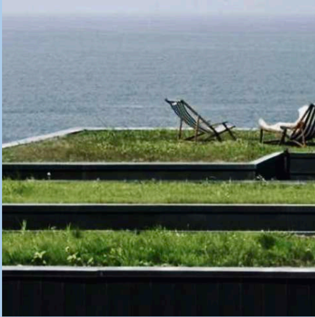
Figura. 11. Techos verdes Fuente: Dominio Web
