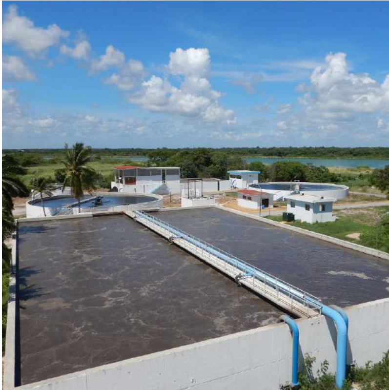
Figura 51: Planta de Tratamiento de Aguas Residuales por lodos activados y un Estero como cuerpo receptor del efluente. Por: RMLV.
