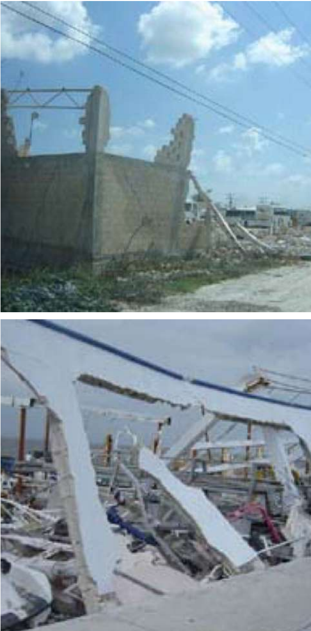
Figura 35: Ejemplos de daños en muros de mampostería perimetrales. Después del paso de Huracán Wilma, Cancún 2005. Fuente: SMIE
