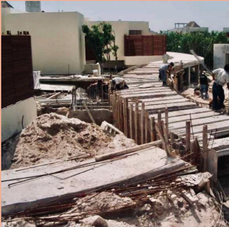
Figura 19: Colocación de tapas de trinchera. Por: LAAG.
