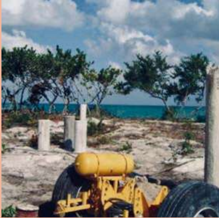
Figura 11: Pilotes en zona de playa. Fuente: LAAC.
