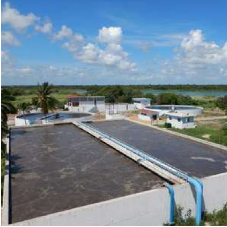
Figura 51: Planta de Tratamiento de Aguas Residuales por lodos activados y un Estero como cuerpo receptor del efluente.
