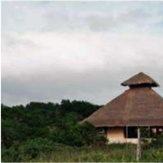
Figura 19: Cubierta autoventilada tipo palapa. Por: MMD.
