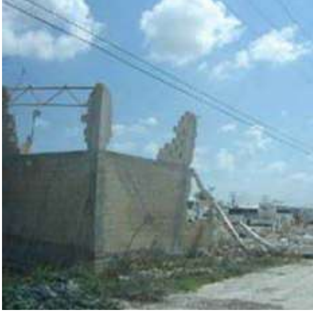
Figura 35: Ejemplos de daños en muros de mampostería perimetrales. Después del paso de Huracán Wilma, Cancún 2005. Fuente: SMIE
