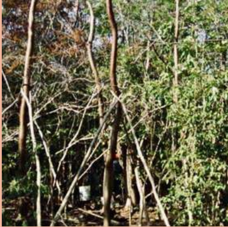
Figura 09: Marcado de área de desplante. Por: LAAC.
