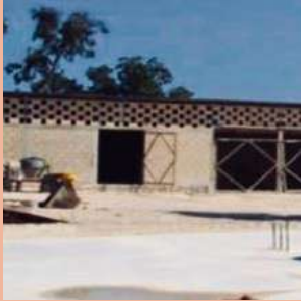
Figura 04: Bodega de obra. Por: JMMM.
