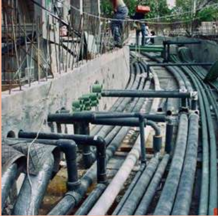
Figura 18: Instalaciones de trinchera. Por: LAAC.
