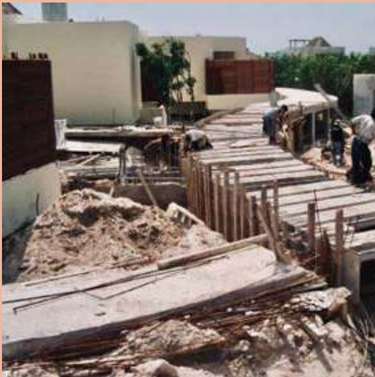
Figura 19: Colocación de tapas de trinchera. Por: LAAG.
