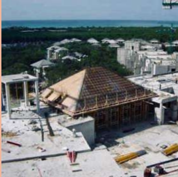
Figura 16: Construcciones de concreto Por: LAAC
