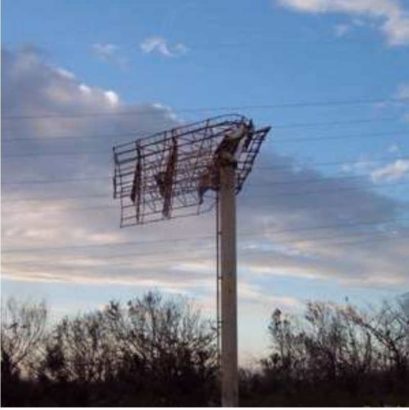
Figura 04: Estado límite de servicio. Falla por acción de empuje del viento Por: A&D Asociados.
