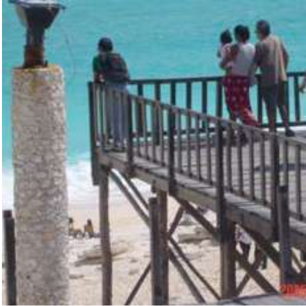
Figura 41: Mirador en playa de Iquitos sin daño por el paso del huracán Wilma. Por: A&D asociados.
