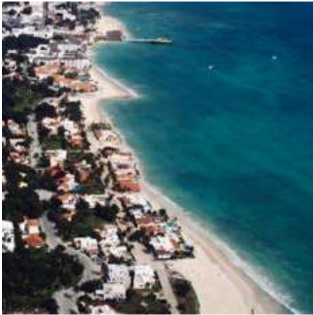
Figura 42: Sedimentación y erosión costera (norte y sur respectivamente) generada por el muelle fiscal de Playa del Carmen (vista oblicua). Por: ASK.
