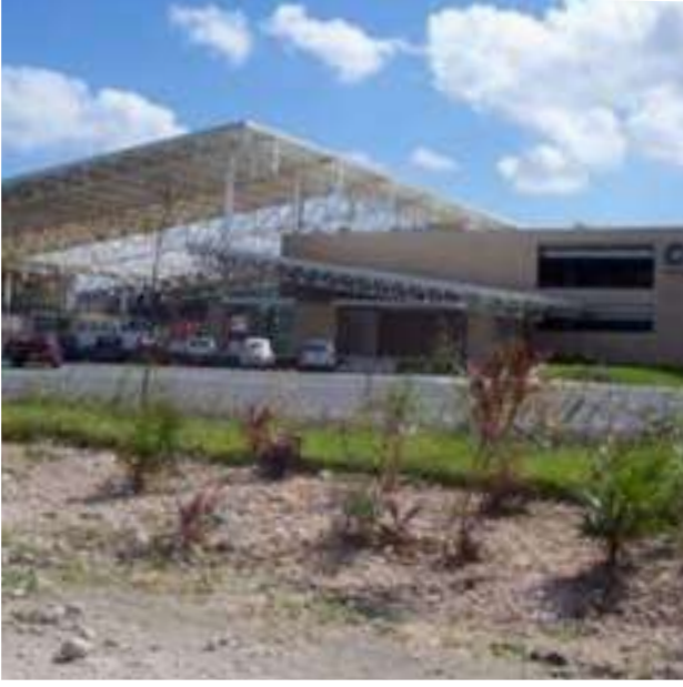
Figura 33: Ejemplos de Techos de Lámina Metálica. Por: A&D asociados.
