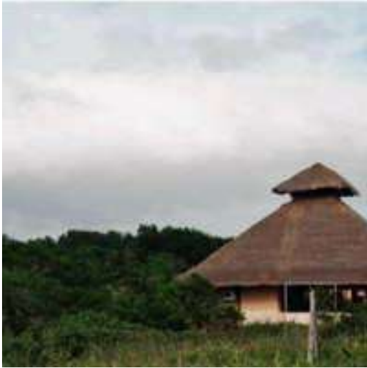
Figura 19: Cubierta autoventilada tipo palapa. Por: MMD.
