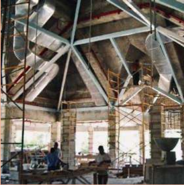
Figura 15: Construcción de estructura con losa de concreto. Por: LAAG.
