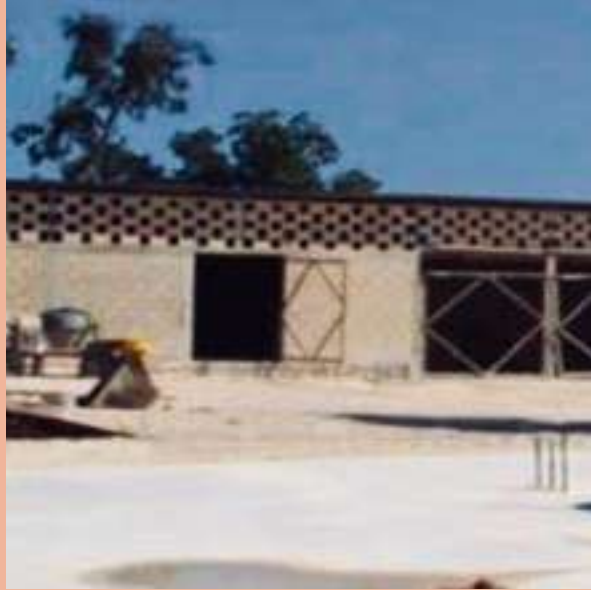
Figura 04: Bodega de obra. Por: JMMM.
