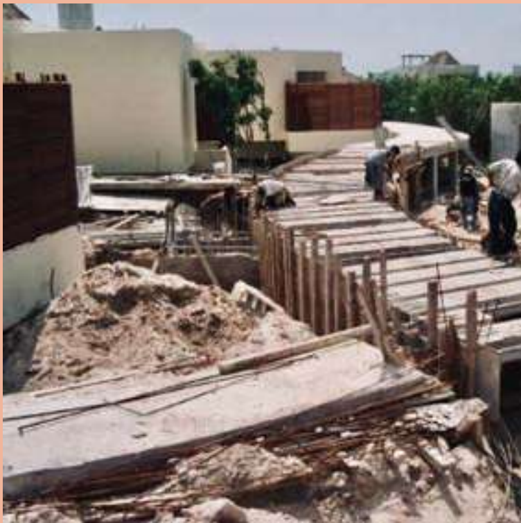
Figura 19: Colocación de tapas de trinchera. Por: LAAG.
