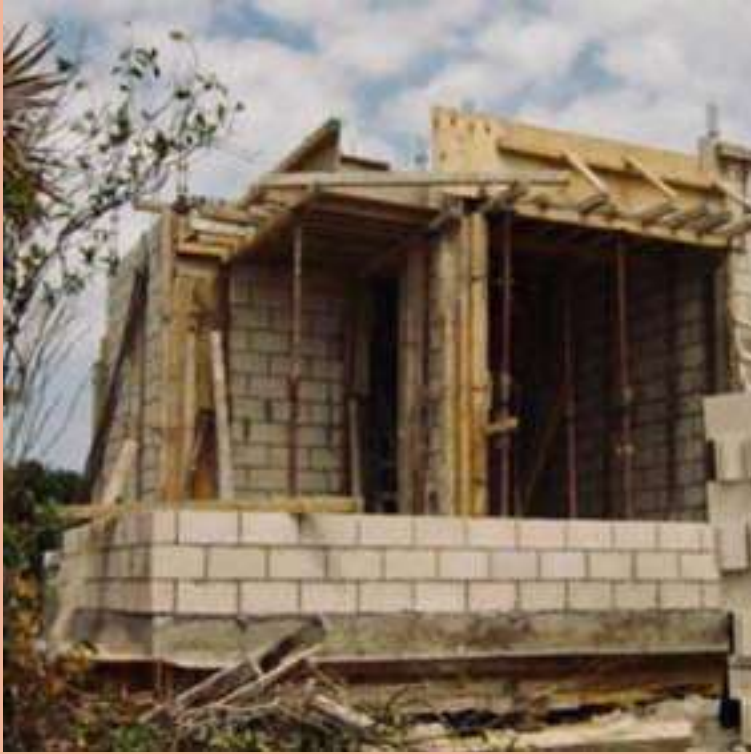
Figura 17: Construcción a base de block de concreto. Por: LAAG.
