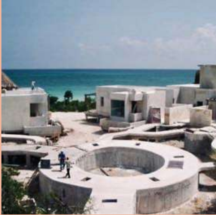
Figura 20: Trinchera terminada que servirá como rodamiento. Por: LAAG.
