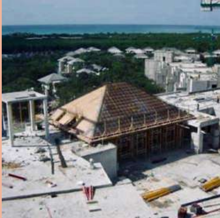
Figura 16: Construcciones de concreto Por: LAAC
