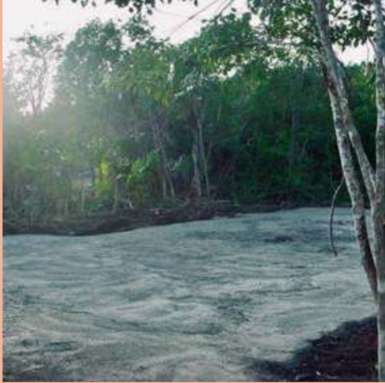
Figura 14: Remate de losa de concreto ciclópeo para desplante de cimentación. Por: LAAG.
