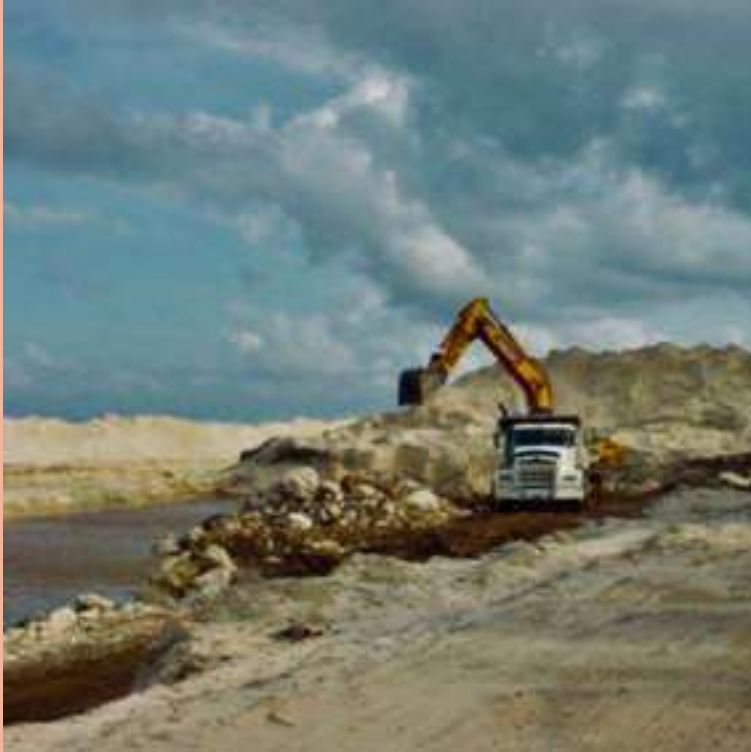
Figura 13: Etapa de excavación hasta estrato resistente. Por: LAAC
