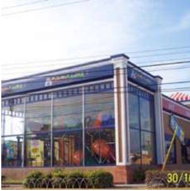
Figura 22: Elementos no estructurales. Cancelería exterior en buenas condiciones después del huracán Wilma Por: A&D asociados.
