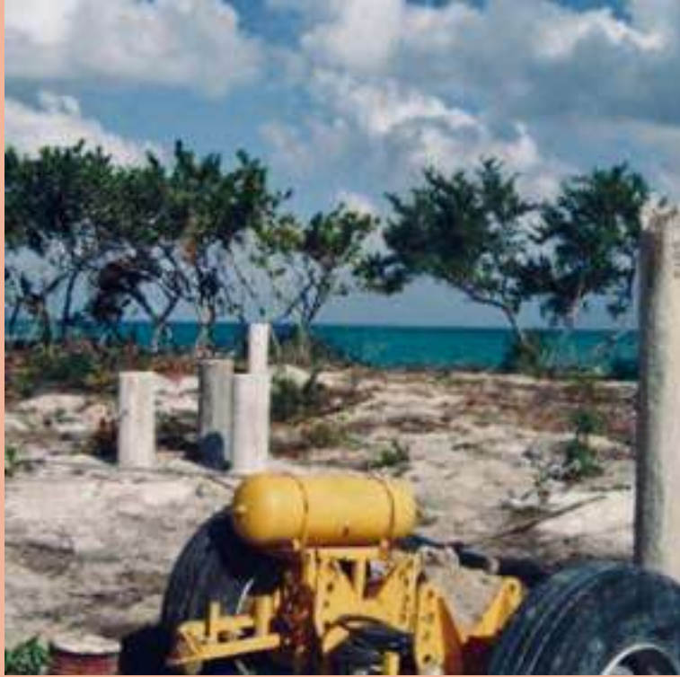
Figura 11: Pilotes en zona de playa. Fuente: LAAC.
